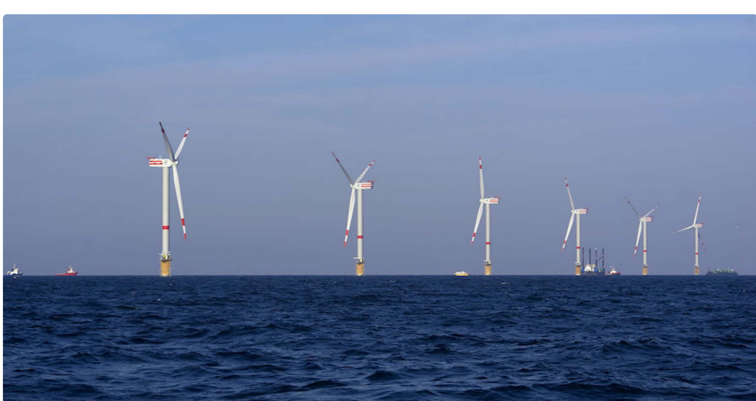
Éoliennes offshore de Thornton Bank en Belgique
